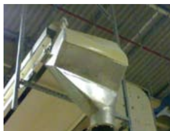
Bandinella di contenimento alimento in caduta su tramoggia.
